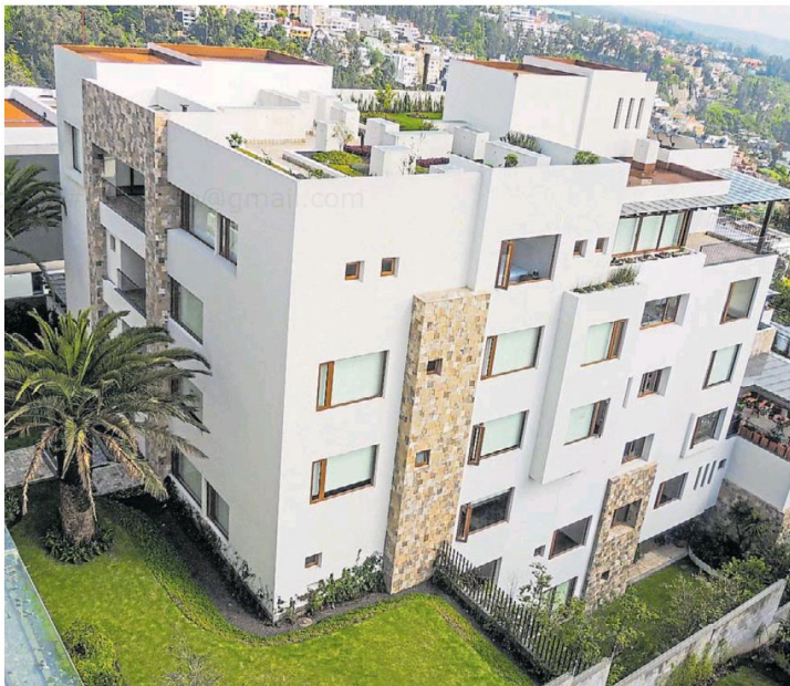
INTERNACIONAL. Complejo en Ecuador con aberturas con perfiles de la línea en Golden Oak.
